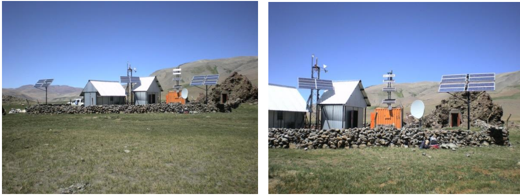
Fig.52. Estado actual de la estación instalada en el Volcán Peteroa, Malargüe, Mendoza, Argentina.
